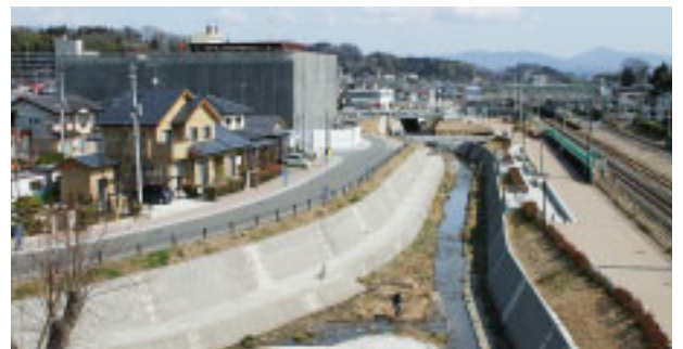
▲建設が進む市民交流拠点施設と竣工した六角川
