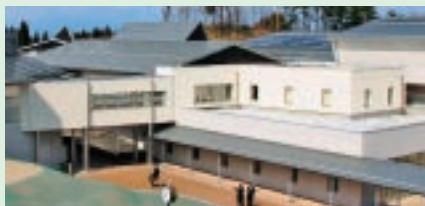
新設された東和小学校
