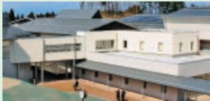
新設された東和小学校
