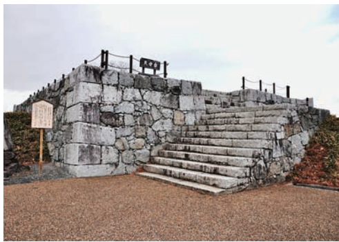
▲本丸天守台修復完成
