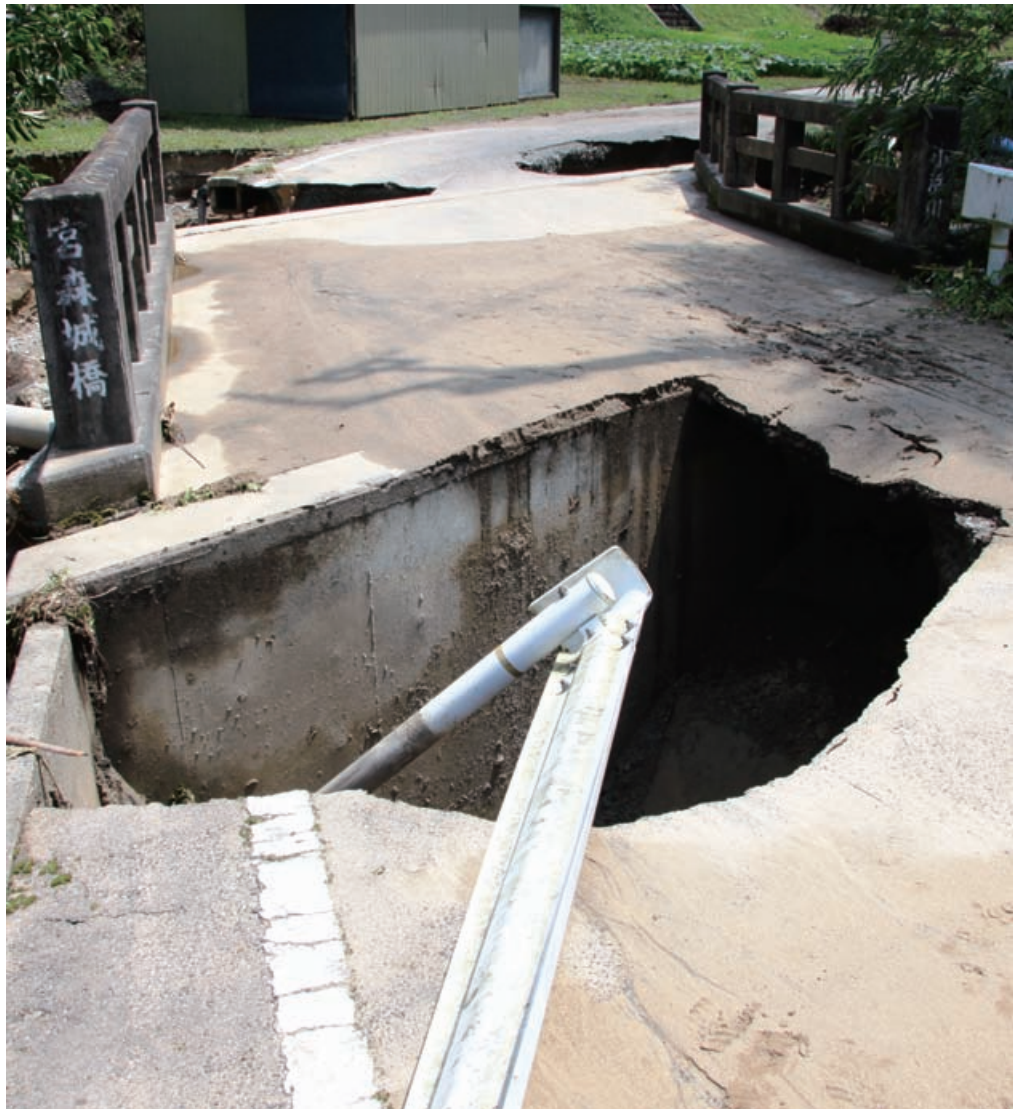
▲8月5日豪雨での被害(小浜地内、宮森城橋)
