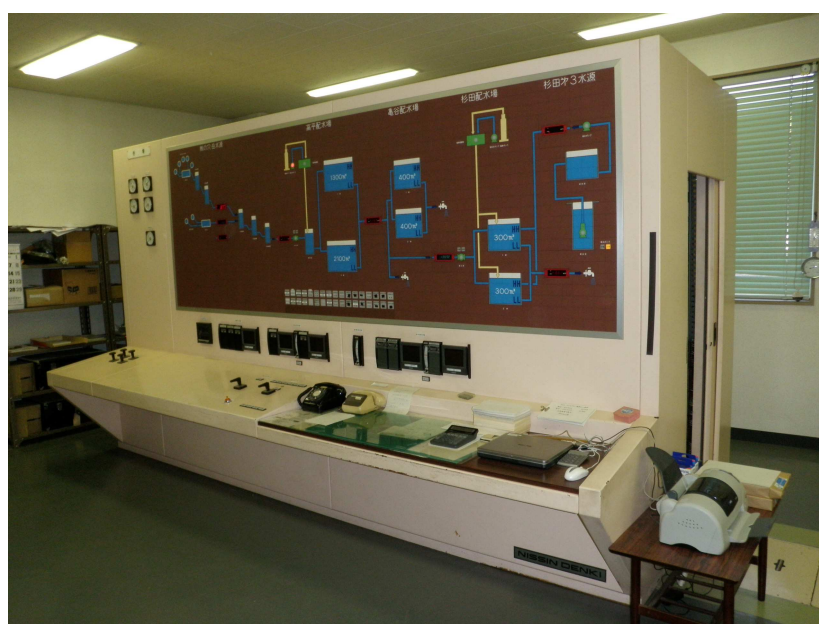
高平配水場監視室
