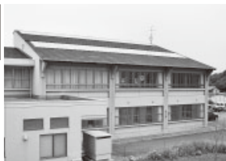
石井小学校の太陽発電装置
