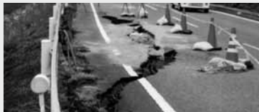
地震による路盤の沈下(十郎内地内)
