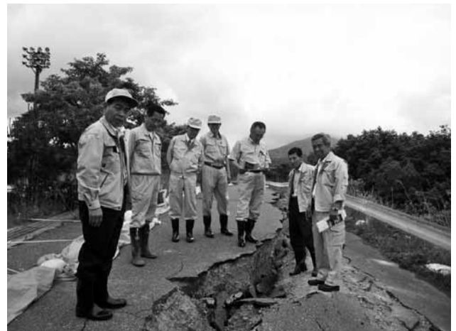
海老内線災害復旧工事の説明を受ける様子
