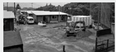
グラウンドに建設された仮設住宅
