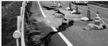
地震による路盤の沈下(十郎内地内)
