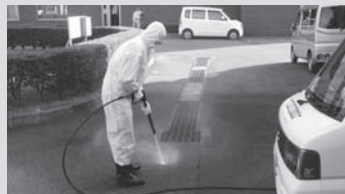
除染作業の様子
