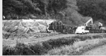
針道地区内の仮置場
