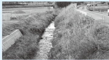
護岸未整備の轟川(駅東)
