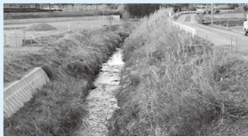
護岸未整備の轟川(駅東)
