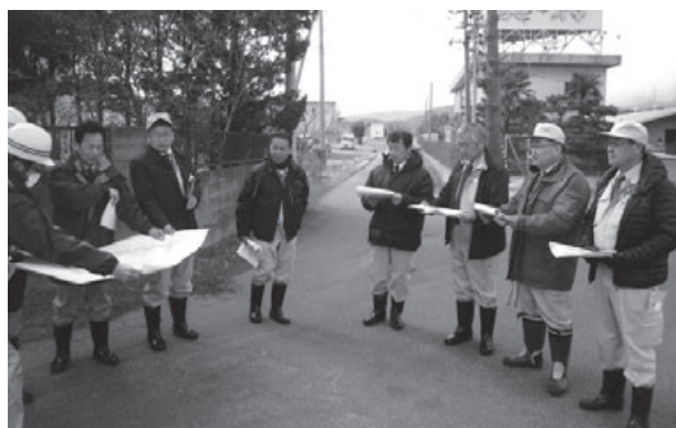
現地調査の様子（長命1号線道路改良工事）
