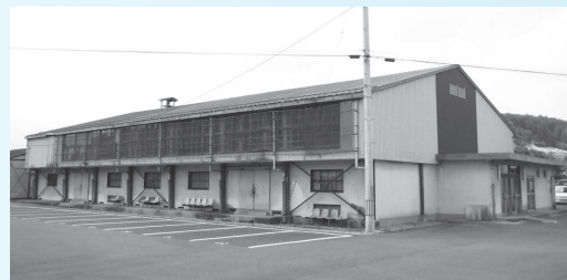
改修予定の杉田住民センターの体育室
