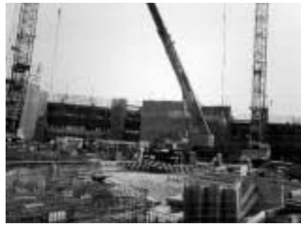
建設現場の風景
