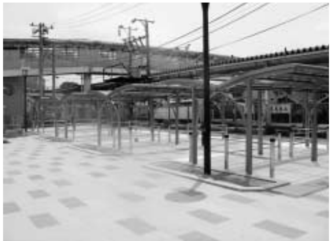
新設された駅西側自転車等駐車場
