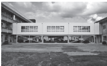
耐震補強工事が完成した東和中渡り廊下
