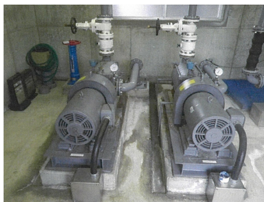
[城山ポンプ場]
