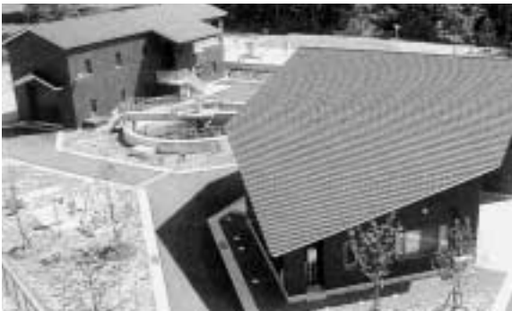
▶岳せせらぎセンター全景
