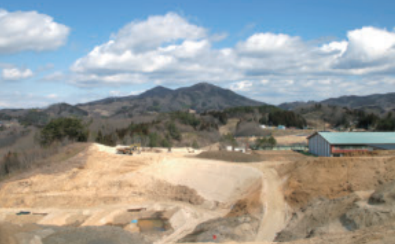
▲着々と進む東和統合小学校工事
