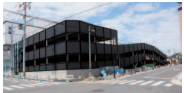
▲立体駐車場(北東より)
