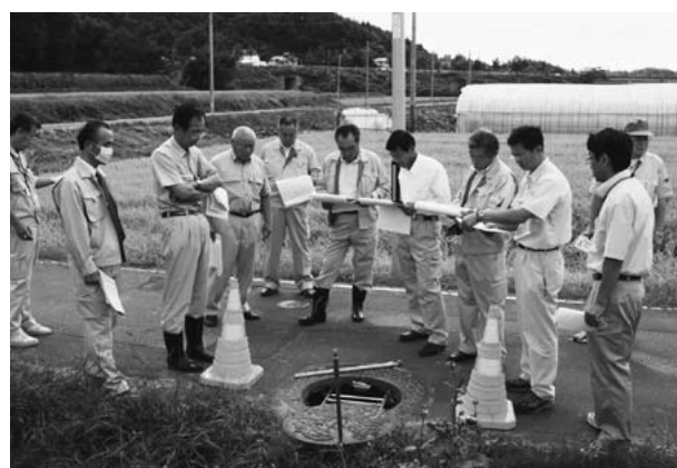
一斗内第1マンホールポンプ施設の説明を受ける様子
