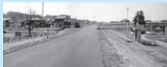
(阿武隈川 安達ヶ原地内樋門)
