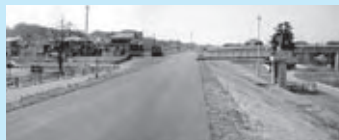
(阿武隈川 安達ヶ原地内樋門)
