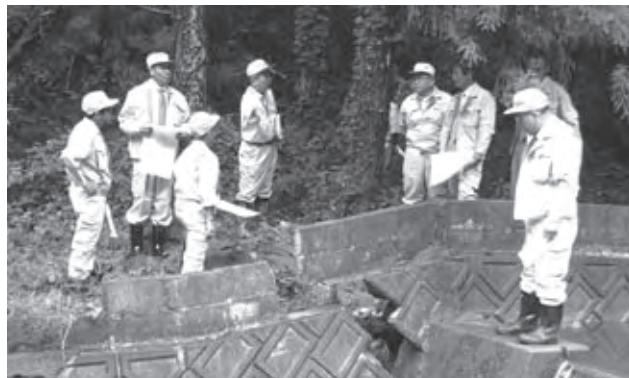
農業用施設災害復旧 堰補修（若林）上太田地区の説明を受ける様子
