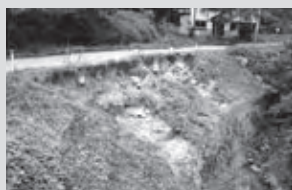
(7月15日の豪雨により路肩崩壊した市道)
