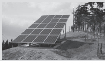
東和小学校敷地内に設置された太陽光発電システム
