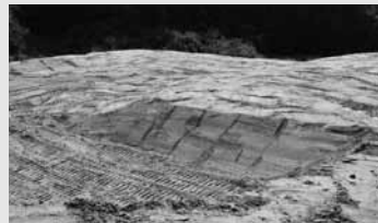
市内に設置された仮置場
