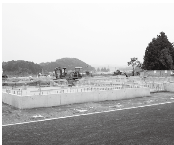
建設中の道の駅「安達」下り線施設
