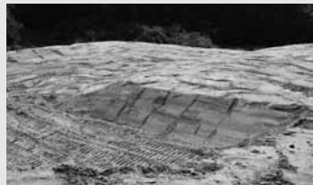
市内に設置された仮置場
