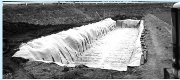
作業中の仮置場(埋設型)
