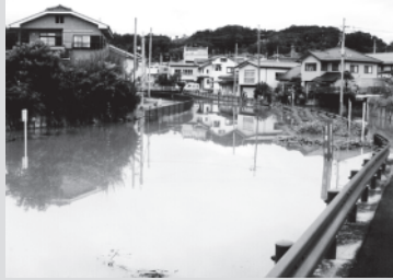
油井字八軒町地内の冠水状況
