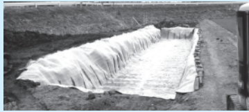
作業中の仮置場(埋設型)
