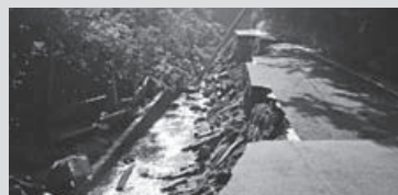
豪雨により寸断された市道
