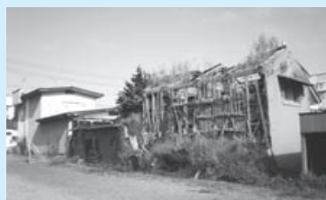
老朽化した空き家
