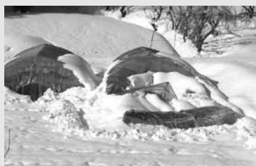
大雪により倒壊したハウス
