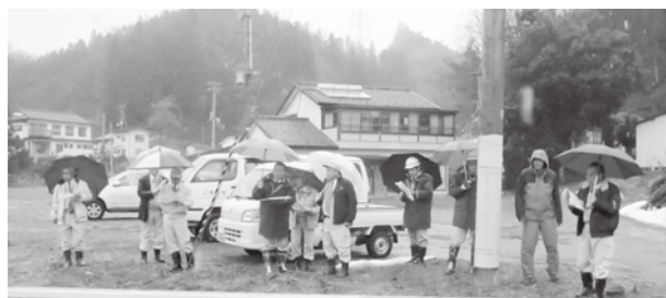
下田橋配水管布設工事箇所の現地調査の様子
