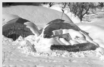
大雪により倒壊したハウス
