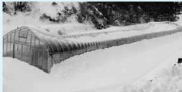
大雪により被害を受けたパイプハウス
