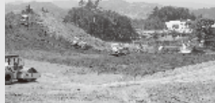
根柄山地内の造成工事の様子
