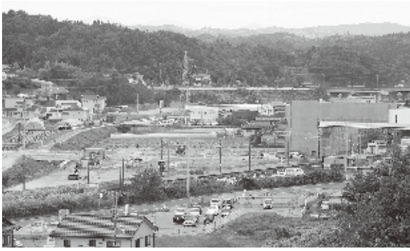
整備が進む安達駅東地区
