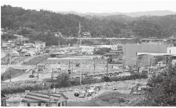
整備が進む安達駅東地区
