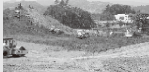
根柄山地内の造成工事の様子
