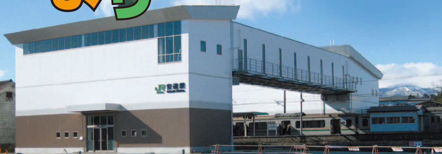
完成間近の新安達駅舎東口
