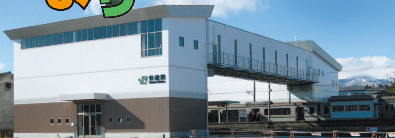
完成間近の新安達駅舎東口
