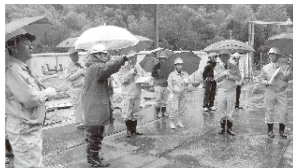
現地調査の様子(二本松市東部給食センター)
