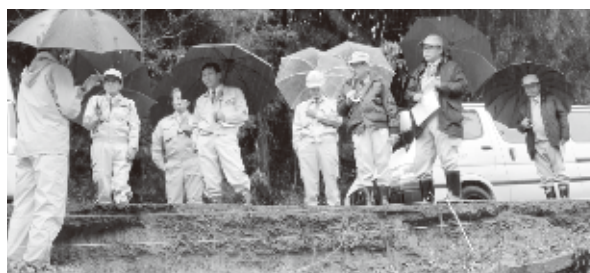
現地調査の様子(戸沢 植柳線)
