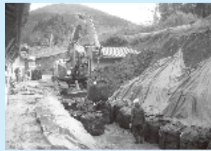
敷地内保管土壌の移送作業(針道地内)
