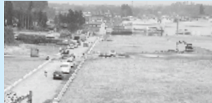
200戸の復興公営住宅を建設中(石倉地内)
