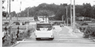
歩道設置予定の油王田踏切
