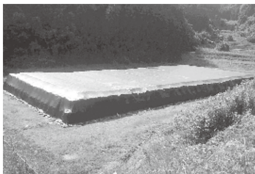
市内の仮置き場
