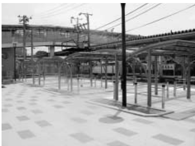
新設された駅西側自転車等駐車場
