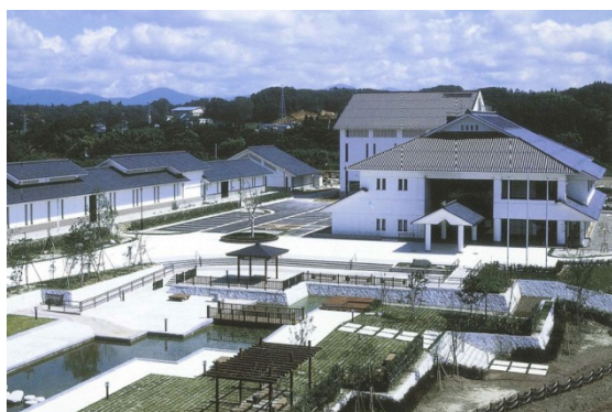
あだたら清流センター（下水道処理施設）
