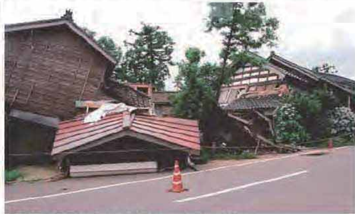
倒壊した被災家屋（平成19年新潟県中越沖地震）
