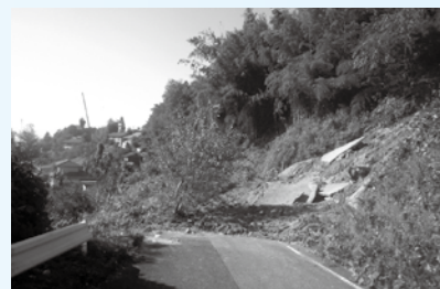
台風21号による被災箇所 (木幡 梨木内・黒木内線)
